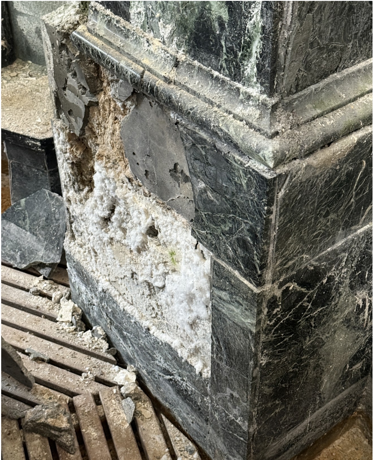
Abb. 8: Abfallende Sockelplatten und die Bildung auftreibender Stoffe durch eindringende Feuchte
